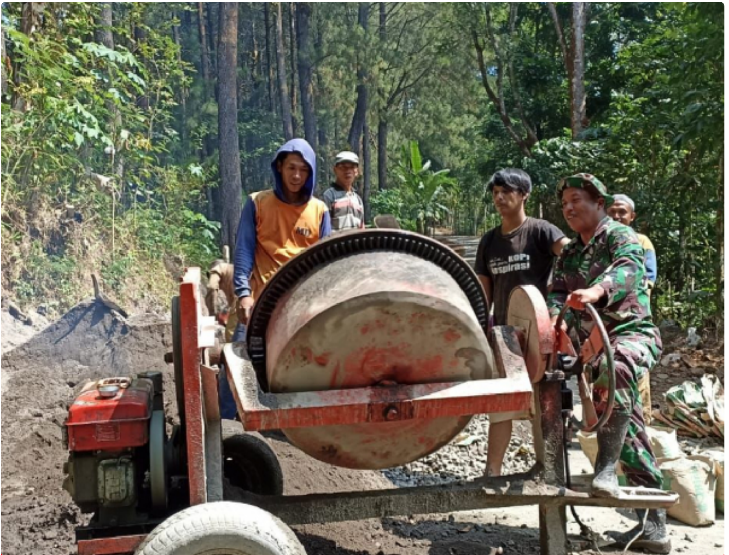
Satgas TMMD kebut pengecoran jalan
