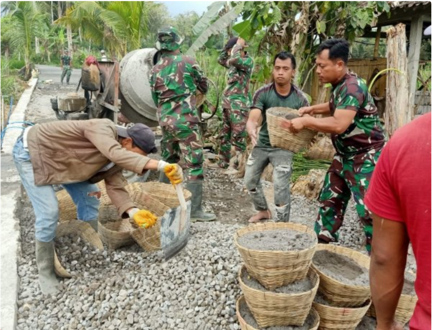
Satgas TMMD Sengkuyung bersama warga bahu membahu mengerjakan cor blok jalan
