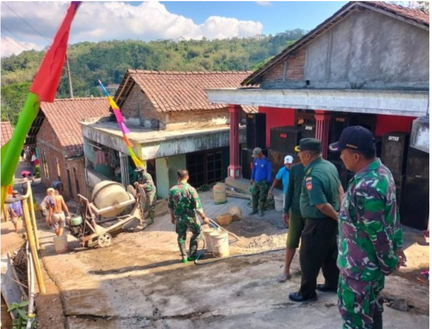
Kasdim Magelang Cek pengerjaan sasaran fisik TMMD sengkuyung di Kecamatan Bandongan
